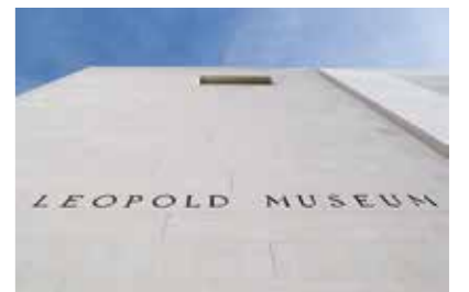
Façade en calcaire coquiller blanc
