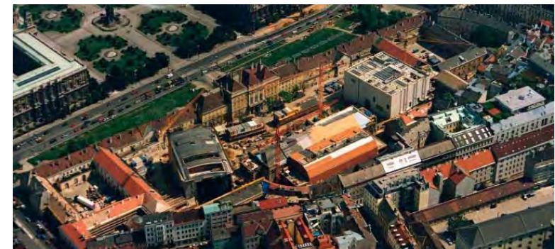
Bilder: Österreichs größte Baustelle: Das Atrium des Museums im Bau, Fundamentarbeiten, Dacharbeiten, Bauhütten im MuseumsQuartier, der Muschelkalk wird angebracht, der Betonkern des Hauses, Elisabeth Leopold auf der Baustelle
